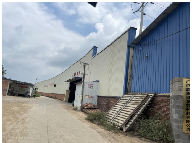
项目厂界西面
