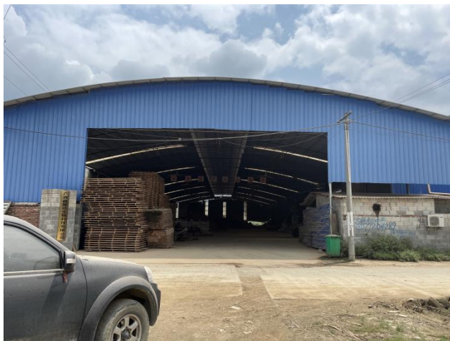
项目现状照片 2
